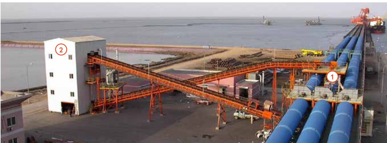
Probenahme (1) und Probenaufbereitung (2) von Kohle während der Schiffsbeladung
